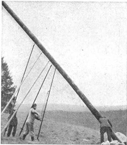
Leitungsbau im Kanton Bern mit LIFTY Stangenwinde
