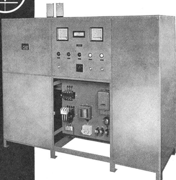
Gleichrichter für Elektrolyseur mit umschaltbarer Spannung 12 V 24 V und Konstantstrom-Regulierung 2000/1000 A, mit ölgekühltem Selen-Element.
