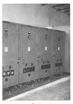
Fig. 1 Gekapselte Verteilanlage mit einer Sammelschiene in einem Unterwerk
