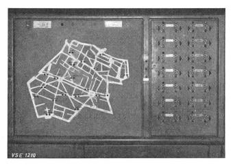
Fig. 12 Im Verteilzentrum eingebautes Blindschema mit Signallampen
