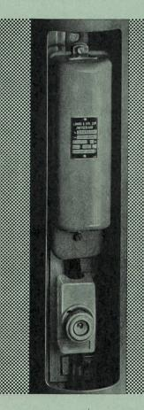
Fernsteuer-Empfänger für 1 Doppelkommando in Kandelabermast eingebaut
