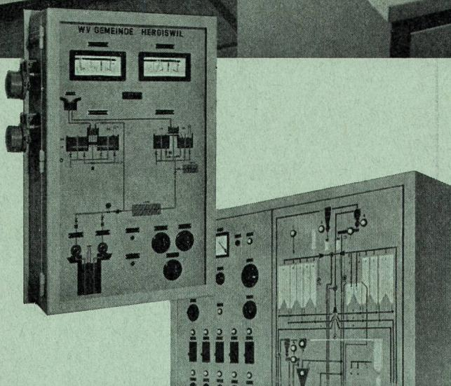
Wir liefern Steuerpulse und Überwachungstafeln für Förder- und Aufbereitungsanlagen mit farbiger Leucht- und Symbol-Bilddarstellung zur Erkennung der Förderwege, des Programm-Ablaufes und des momentanen Betriebszustandes.
