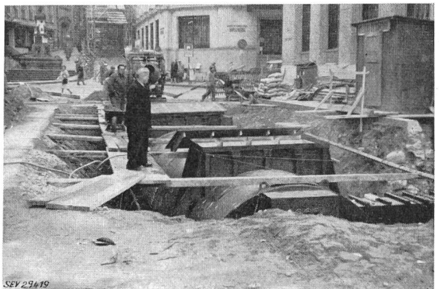
Fig. 2 La cabine posée dans la rue
