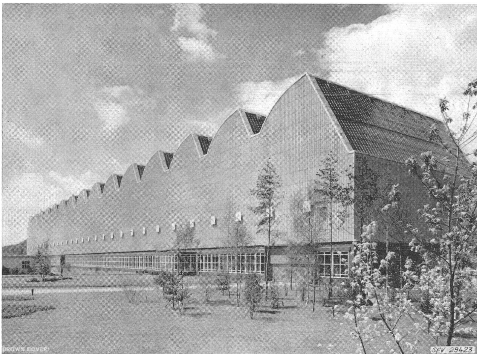
Fig. 1 Haupthalle Länge 270 m, Breite 36 m, Höhe 32 m
