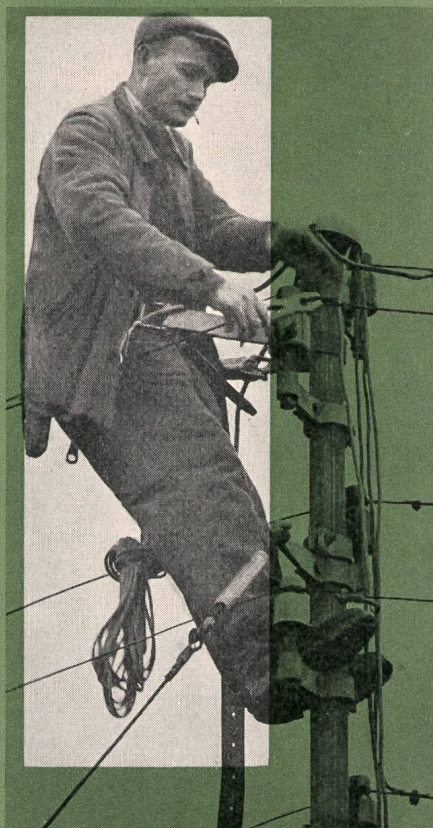
Freileitungsmonteur an der Arbeit auf einem Dachständer
