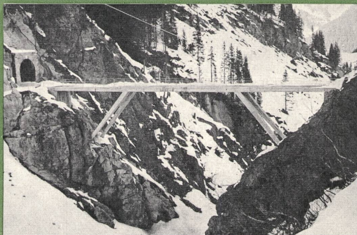
Der Bau der Kraftwerke Vorderrhein erforderte die Erstellung neuer und den Ausbau bestehender Strassen. Bild: Neuerstellte Brücke über den «Rein de Nalps».
