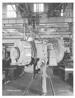
Fig. 4 Abgasturbolader für die Leistungssteigerung von Dieselmotoren
