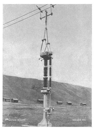
Fig. 2 Einsäulentrenner für 245 kV und 2000 A Nennstrom
