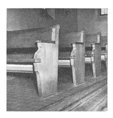
Fig. 2 Kirchenheizung mit Infrarot-Bankstrahler
