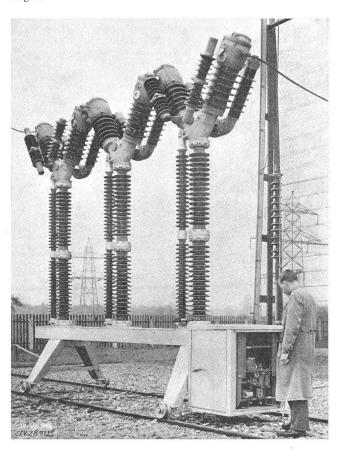
Fig. 1 Ölstrahlschalter HPF 514 für 245 kV
