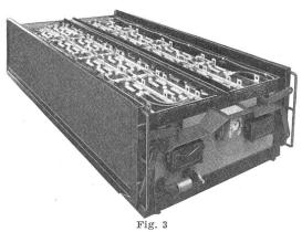
Spezialeinbau-Batterie für Stollenlokomotiven
