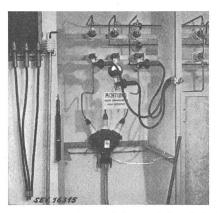
der geerdeten Kontakthülse entladen und durch Aufsetzen auf die konischen Kontaktzapfen die Anlage geerdet und kurzgeschlossen. Das Gerät darf nur von fachkundigen Personen, die vom verantwortlichen Betriebsorgan ausdrücklich bevollmächtigt sind, gehandhabt werden.
