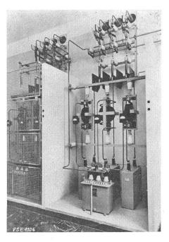
Fig. 4 11-kV-Kopplungszellen für die Netzkommandoanlage der Stadtwerke Cremona (Italien)
