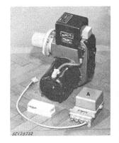
Der Ölbrenner hat die Prüfung in bezug auf die Sicherheit des elektrischen Teils bestanden. Er entspricht dem «Radioschutzzeichen-Reglement» (Publ. Nr. 117). Verwendung: in trockenen Räumen.
