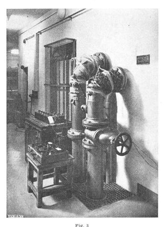
Fig. 3 Einrichtung zur Messung der Temperaturen des Kühlwassers
