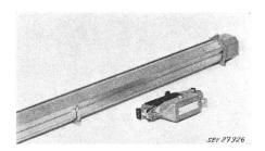
Die Stromabnehmerschiene hat die Prüfung in sicherheitstechnischer Hinsicht bestanden. Verwendung: in feuchten Räumen.
