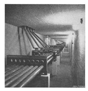
Fig. 7 Gleichstrom-Sammelschiene
