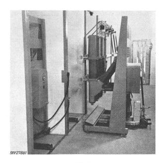
Fig. 3 Ausfahrbarer Ölstrahlschalter für 30 kV in Transportstellung
