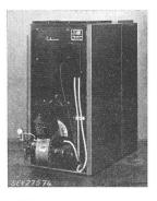
tor. Antrieb von Druckpumpe und Gebläse durch Einphasen-Kurzschlussankermotor mit Hilfswicklung und Zentrifugalschalter. Zündtransformator über dem Ventilator montiert. Angebauter Schaltkasten zur automatischen Steuerung des Lufterhitzers, mit eingebauten Thermostaten und Kipphebelschalter für Gebläse. Motorschutzschalter für Druckpumpe vorhanden. Zuleitung Gummiaderschnur mit Stecker 2 P+E, fest angeschlossen.
