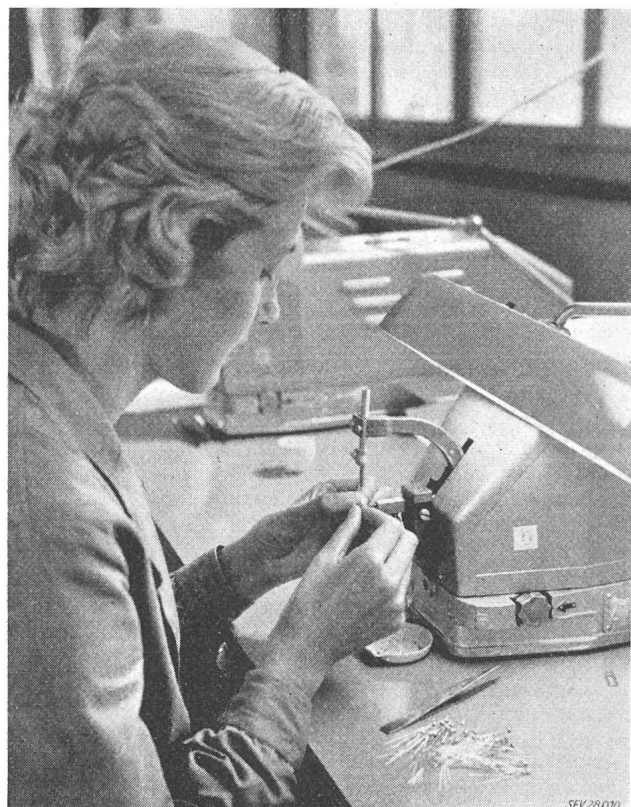
Fig. 3 Aufpunkten des Transistorelementes auf den Boden
