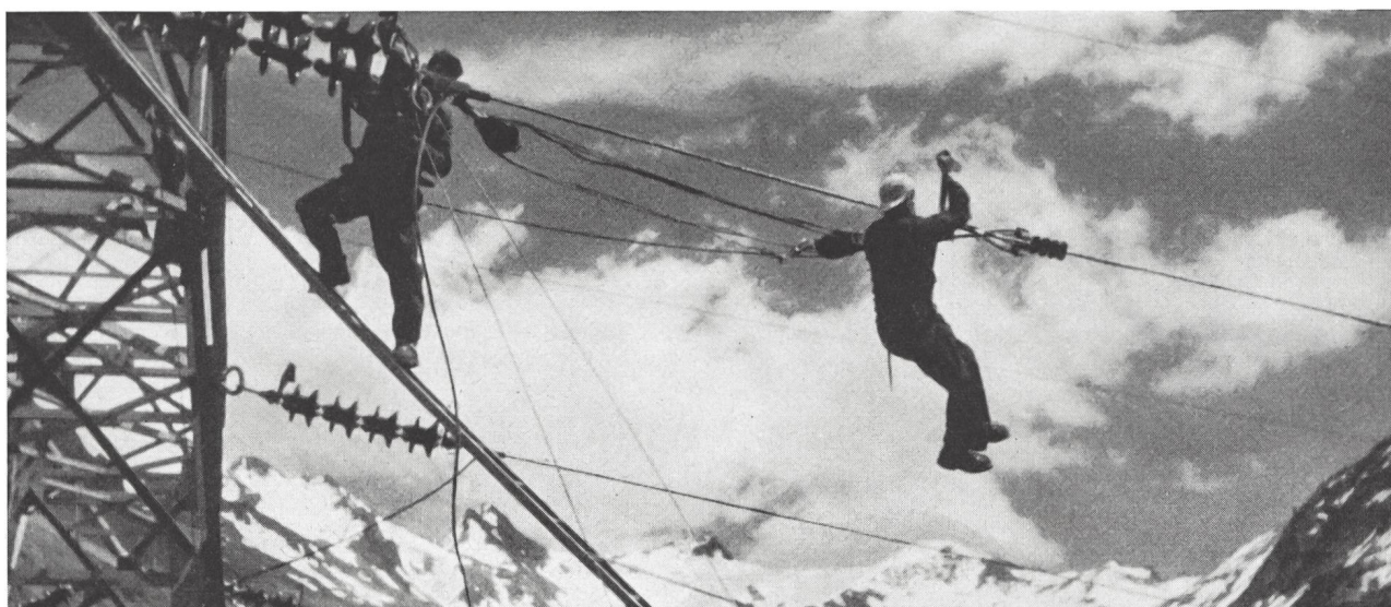
Fig. 19 Reparaturarbeiten an der Gotthard-Leitung
