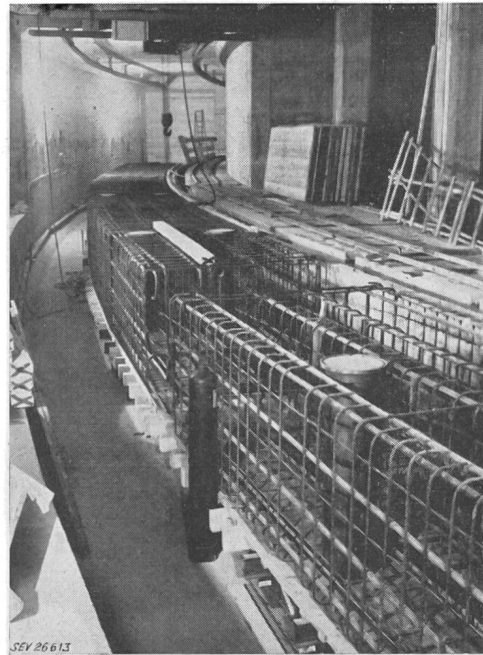
Fig. 7 Armature de l'anneau du PS (1957)
