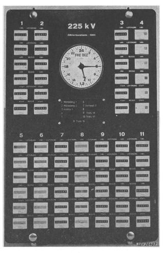
Fig. 13 Zählertafel mit eingebauter Kalender-Uhr
