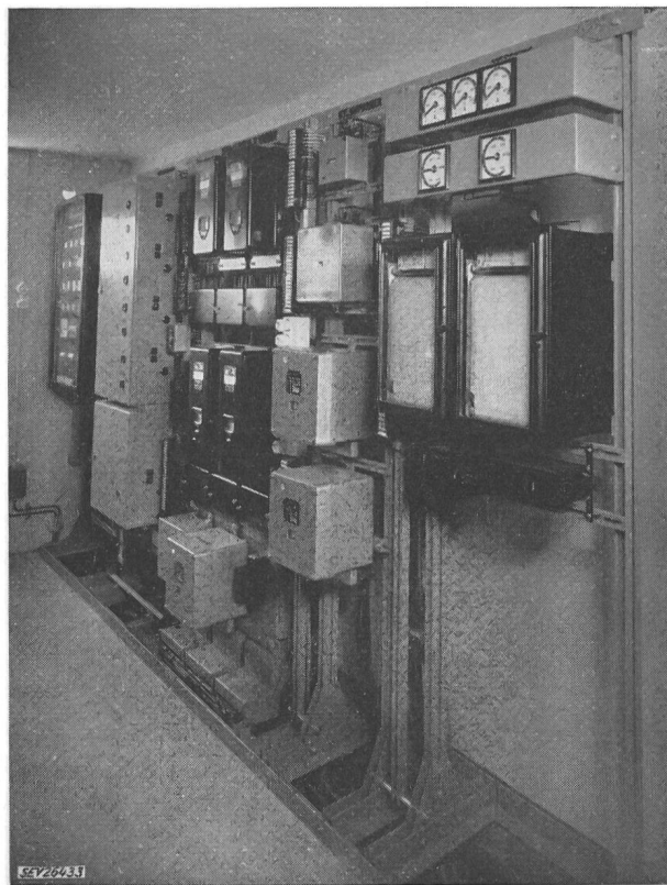
Fig. 9 Relaisstation der Freiluftanlage «Kaisterfeld»
