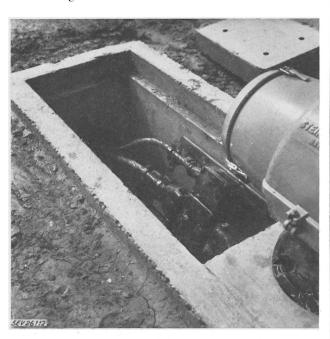
Fig. 12 Lampenschacht mit Abzweigkasten aus Gusseisen und mit Kabelendverschlüssen auf Eisenrahmen montiert
