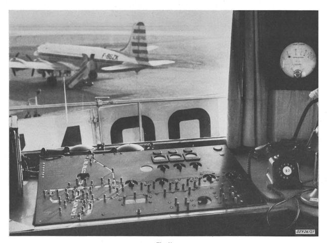
Fig. 21 Leuchtschaltpult im Kommandoturm für die gesamte Pistenbefeuerung mit Blick auf den Flugzeugabstellplatz
