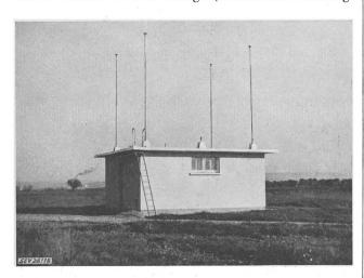
Fig. 16 Empfängerhäuschen mit den 4 Empfangsantennen
