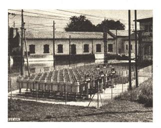
Fig. 3 Die Kondensatoren-Batterie in Luterbach Diese Kondensatoren-Batterie ist auf dem Areal des AEK aufgestellt; sie ist für direkten Anschluss an 10 kV bestimmt
