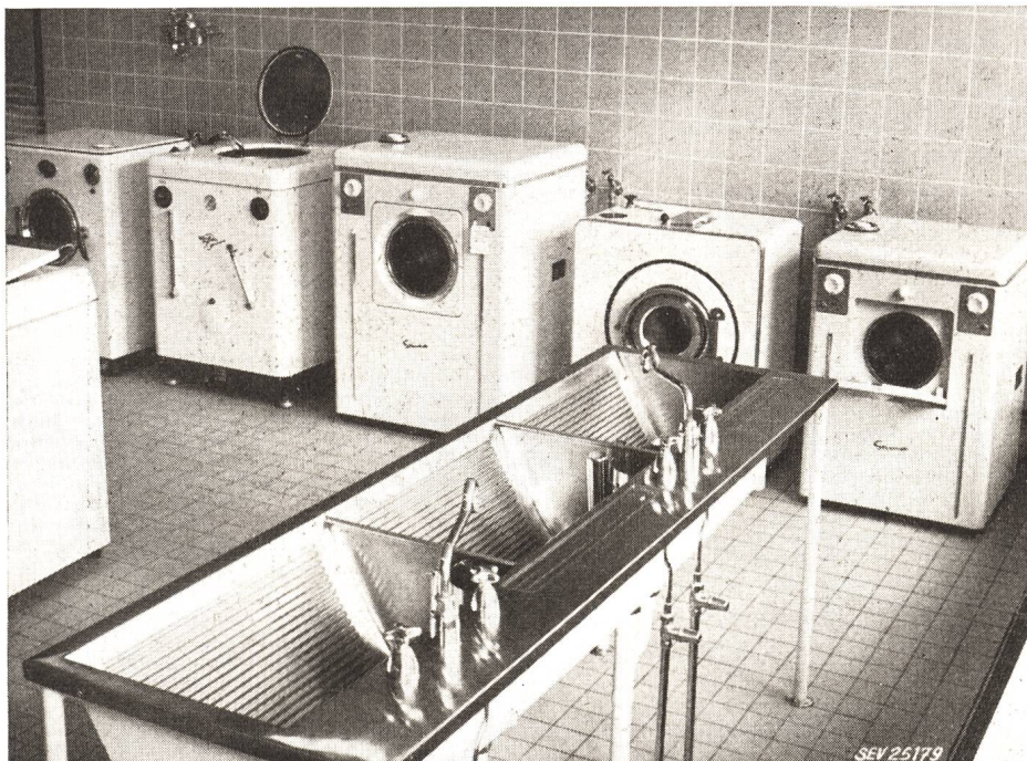
Fig. 7 Teilansicht der Vorführungswaschküche
