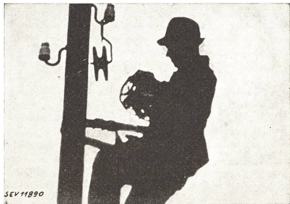
Fig. 4 Unzweckmässige Auslegerolle Zu kleiner Rollendurchmesser
