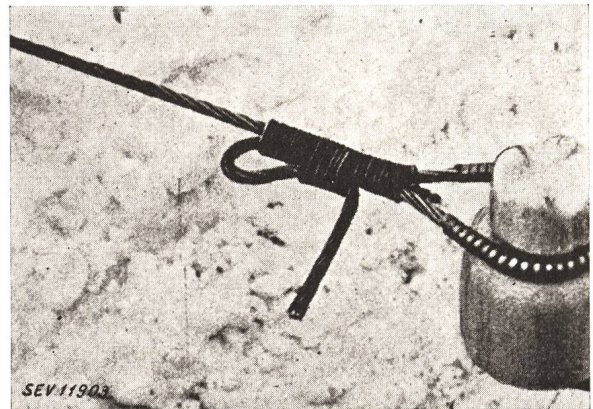
Fig. 17 End- oder Abspannbund, für Leitungsabzweigungen vorgesehen. Man beachte die lange Schlaufe des Leiterseiles
