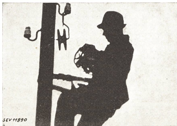
Fig. 4 Unzweckmässige Auslegerolle Zu kleiner Rollendurchmesser
