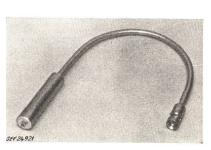
schützt. In einem Messingrohr, das gleichzeitig als Handgriff dient, sind zwei Stabbatterien von je 1,5 V untergebracht. Der aus einem drehbaren Messingteil bestehende Schalter befindet sich auf der Stirnseite des Handgriffes. Die Leuchte ist auch mit einem festen Rohr an Stelle des flexiblen Rohres zulässig.
