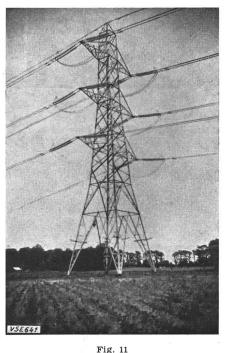
275-kV-Abspannmast mit Doppelbündelleitern
