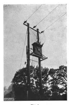
Fig. 9 Dreiphasige «Farmer»-Transformatorenstation mit Niederspannungs-Kabelendverschluss und -Sicherungen
