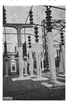
Fig. 1 Betonständer in einer Freiluftstation
