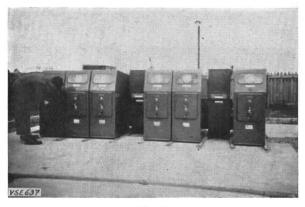
Fig. 7 11-kV-Freiluft-Verteilanlage mit vertikal ausziehbaren Schalteinheiten
