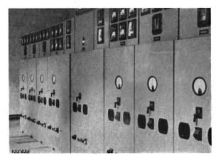
Fig. 6 Verteilanlage mit horizontal ausziehbaren Schalteinheiten
