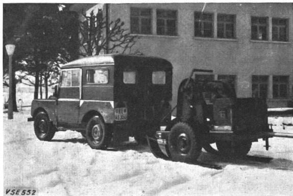
Fig. 8 Fahrzeug der Fig. 7 mit Bauwinde
