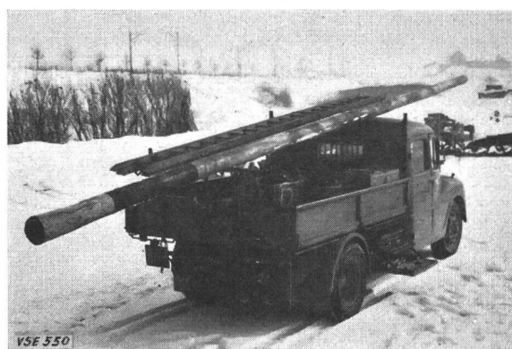
Fig. 6 Lastwagen der Fig. 2: Stangentransport mit Aufsatz
