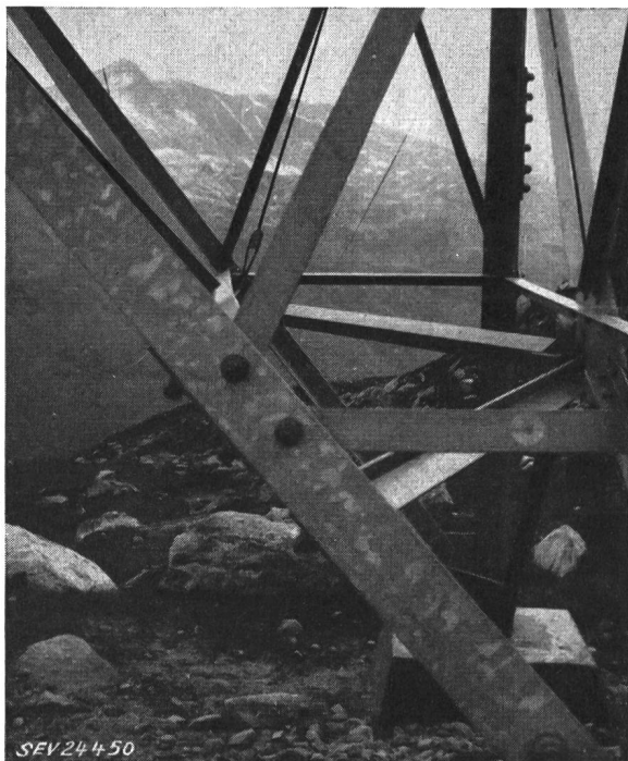
Fig. 7 Derselbe Füllstab wie in Fig. 2 jedoch nach der Montage des Spannseiles
