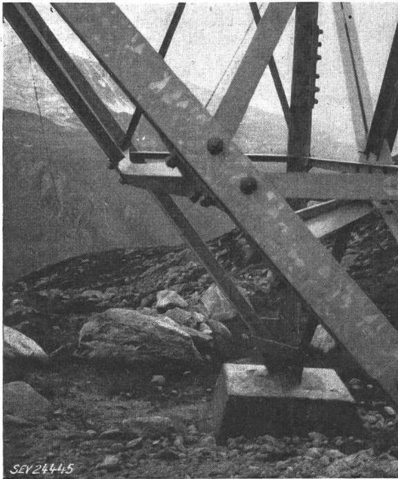
Fig. 2 Ausgebogener Füllstab (Bildmitte)
