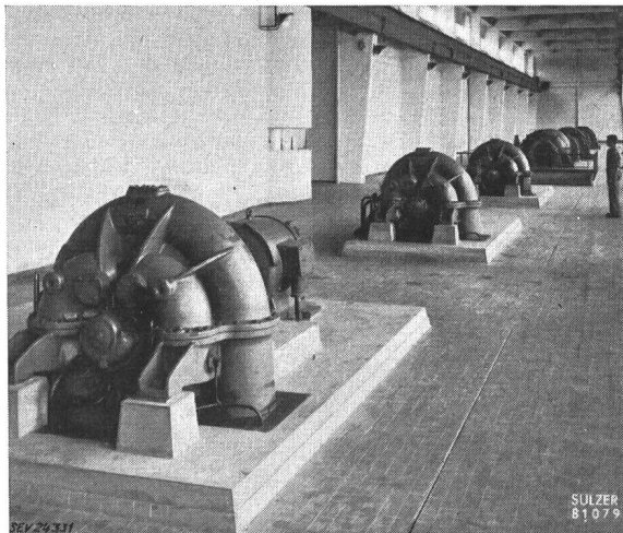
Fig. 2 Maschinenhalle einer grossen Leuchtgasverteilzentrale in Paris. Diese modernste Anlage Europas ist mit drei Sulzer-Radialverdichtern (Vordergrund) und zwei Sulzer-Axialverdichtern (Hintergrund) ausgerüstet.
