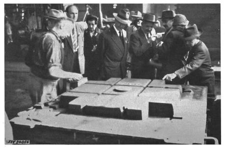
Die Besucher konnten die Arbeiten an einem riesigen Plattenbohrwerk mit einer Antriebsleistung von 51,5 kW (70 PS) verfolgen. Als Arbeitsstück war der Leitradring zu einer Kaplanturbine für das Kraftwerk Rheinau im Gewicht von 50 t aufgespannt.
