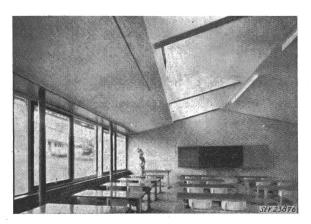
Fig. 2 Einseitig beleuchteter Schulraum mit zusätzlichem Fensterband, einem sog. «Lichtgaden»
