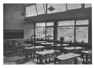
Fig. 1 Einseitig beleuchteter Schulraum mit «Blende» und lichtstreuendem Glas in der oberen Fensterhälfte
