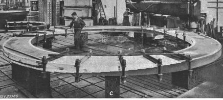
ben, also überlappt aufeinandergestapelt werden (Fig. 9). Die fertigen Ringe werden gewärmt und in warmem Zustand mit dem Armsystem des Rotors verkeilt, so dass für die Nenndrehzahl ein fester Sitz garantiert ist. Wie eingangs erwähnt, kann bei Generatoren mit Kettenrotor kein Schleu-
