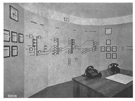
Fig. 1 Lastverteileranlage im Verwaltungsgebäude Olten
