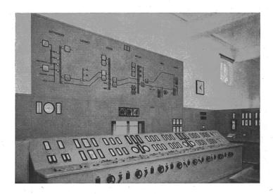
gaben der Instrumente im Lastverteiler von ganz besonderer Wichtigkeit, ist der Bedienende doch mit einem Blick orientiert, welche Leitungen oder Netzteile durch die Störung betroffen oder ausgefallen sind. Ohne zeitraubende Rückfragen kann er gleich die nötigen Weisungen erteilen und so die eventuellen Stromunterbrüche auf ein Mindestmass begrenzen.
