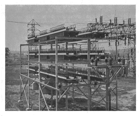
Bei grösseren Anlagen von einigen Tausend kVar werden die Kondensatoren fast immer individuell abgesichert. Das genügt jedoch nicht, vielmehr muss noch ein Relaissystem eingeordnet werden, welches schadhafte Spannungsungleichheiten innerhalb der Batterie aufdeckt. Bei dauernder Überspannung von mehr als 10% an irgend einer Seriegruppe muss «Unbalance-Detection»-System ansprechen. Dies wird fast immer indirekt, d. h. durch Messung der Verschiebung des freien
