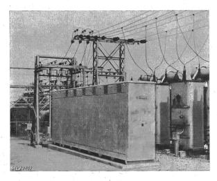
Verschalte Kondensatorenbatterie von 5400 kVar, 7,2/12,5 kV (Näheres siehe in Abschnitt 5)
