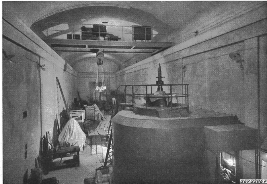
Fig. 13 Usine souterraine Etat des travaux en décembre 1954
