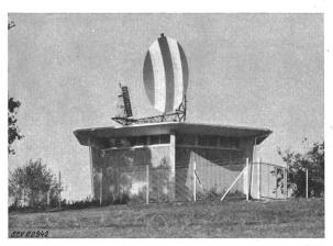
Fig. 1 Überwachungsradar-Gebäude auf dem Holberg Der massive Eisenbetonbau trägt die sich drehende Antenne, welche zufolge ihres 4 m Durchmesser aufweisenden Parabolspiegels starken Winddrücken widerstehen muss
