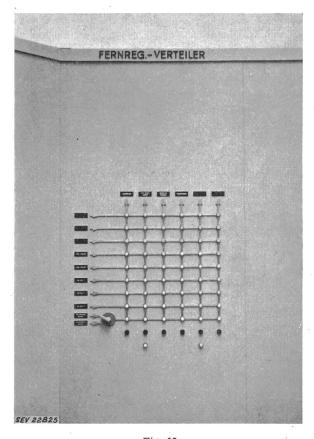
Fig. 15 Verteiler für die automatische Fernregulierung
