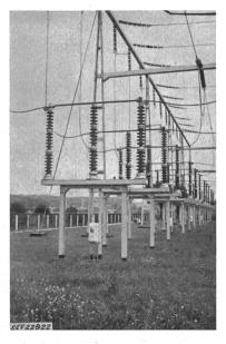
Fig. 12 225-kV-Sammelschienentrenner
