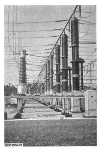
Fig. 11 225-kV-Transformatorenschalter von drei verschiedenen schweizerischen Fabrikanten
