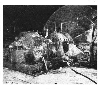
Fig. 1 Einer der beschädigten 100 MW-Generatoren im Richard L. Hearn-Werk
