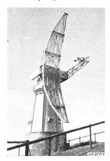
Fig. 17 Höhenfinder-Antenne für Höhenmessungen Reichweite ca. 170 km (Frankreich)
