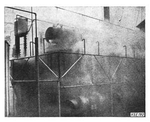
Fig. 20 Brandschutz von Grosstransformatoren durch automatische Wassernebelanlage
