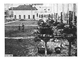
Fig. 8 Unfall mit 125 kV-Oelspannungswandlern Nach einer Störung in einem Spannungswandler wurden 12 derselben durch das brennende Oel zerstört.
