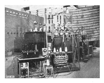
Fig. 13 Prüfung eines Lasttrenners in einem Elektrizitätswerk Messung der Ausschaltzeit mit Schleifen-
