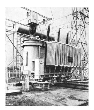
Transformator mit natürlicher Kühlung und zusätzlichen Ventilatoren
