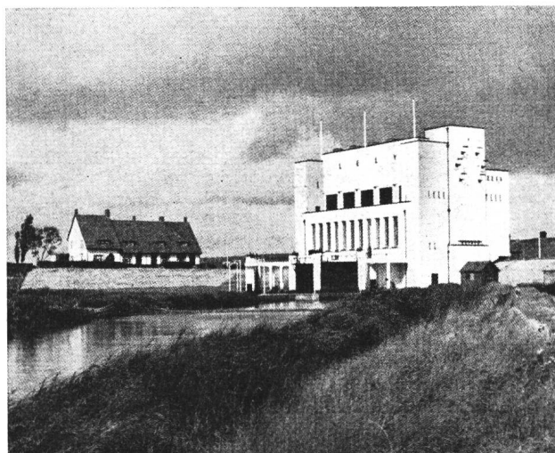
Fig. 5 Das Pumpwerk «Lely»
