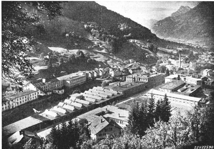
Fig. 1 Die Werkanlagen der Therma A.-G. in Schwanden
