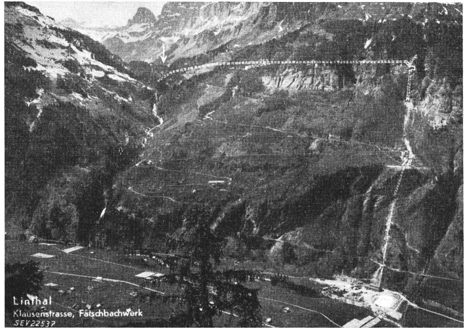
Fig. 1 Linthal: la route du Klausen et la centrale du Fätschbach
