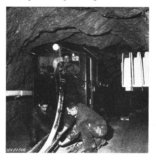
Fig. 19 Verlegung der 150-kV-ölkabel mit Stollenlokomotive
