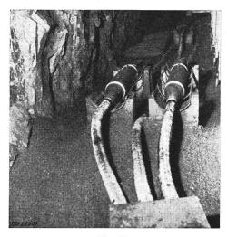
Fig. 20 Kabelstollen Grimsel-Gerstenegg Muffenverbindung der 150-kV-ölkabel
