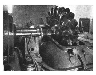
Fig. 10 Laufrad B mit geöffnetem Turbinengehäuse und Stehlager im Maschinenhaus Grimsel
