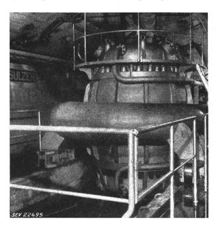
Fig. 15 Ansicht der Speicherpumpe im Untergeschoss des Maschinenhauses Grimsel
