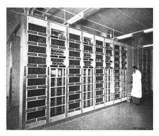
Fertig installierte Telephonzentrale «Hasler System 52» Die Relais- und Suchereinheiten sind vorne mit Glasdeckeln und hinten (zweite Reihe) durch Metalldeckel vor Staub und Beschädigungen geschützt. Hinter den schmalen Metalldeckeln ganz oben und unten verlaufen die Kabel
