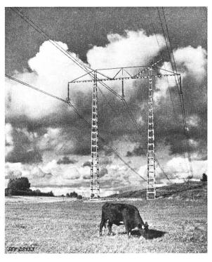
Fig. 5 380-kV-Leitung mit Bündelleitern
