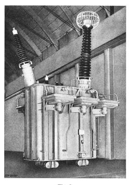
Fig. 3 Einphasentransformator 380/220 kV, 100 MVA (Hallsberg)
