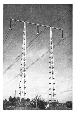
Fig. 6 220-kV-Leitung mit Bündelleitern
