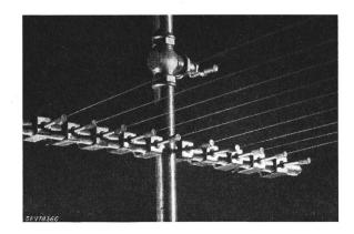
Fig. 8 Verteilrohr mit Einstellvorrichtungen und Düsen (Etage)
