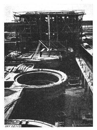
Fig. 2 Die Fundamente für die Kaplanturbinen im Kraftwerk von Tiszalök
