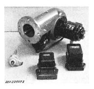
Steuerung durch Photozellen-Flammenwächter, Schaltautomat und Kesselthermostat «Landis & Gyr». Zugluftregulierung «Landis & Gyr».
